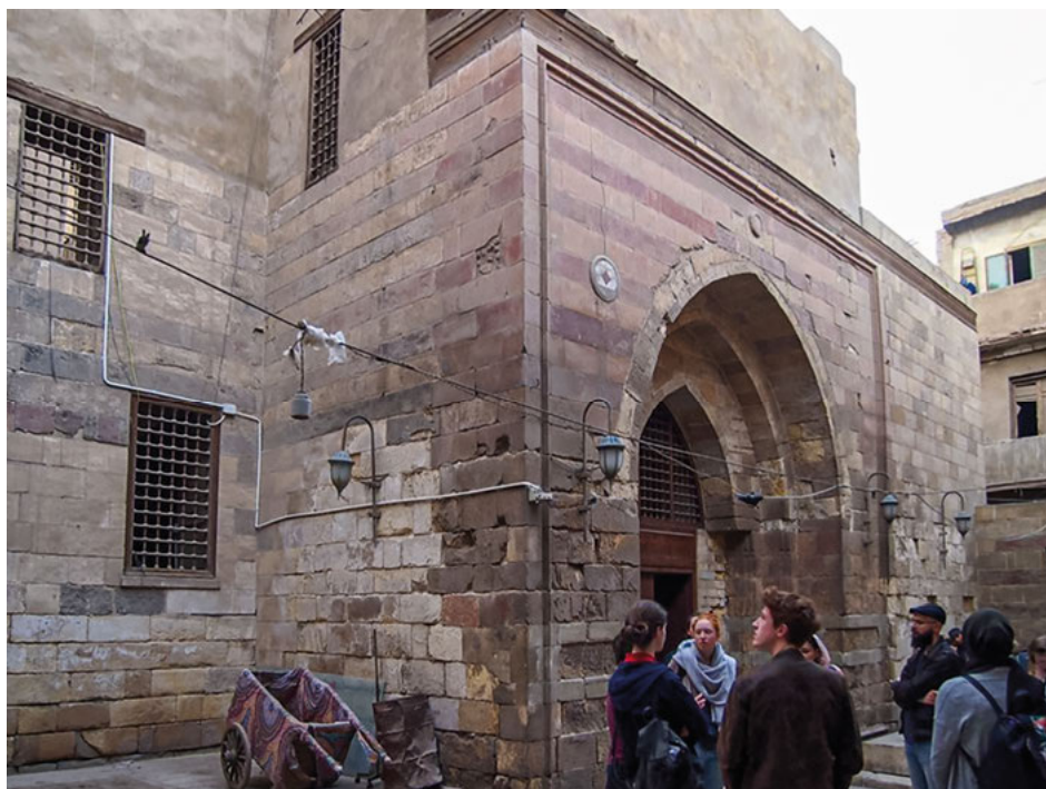
Abb. 4, Eingang mit Emblem, Emir-Baštak-Palast
